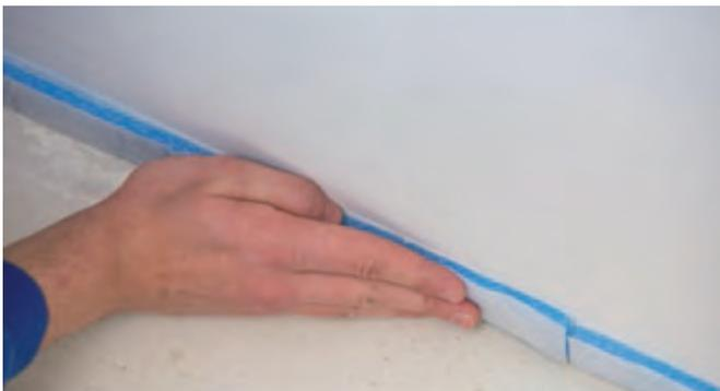
Vor Verlegung der Flächenelemente ist zu angrenzenden Bauteilen und Belagsdurchdringungen der Randdämmstreifen zu verlegen
