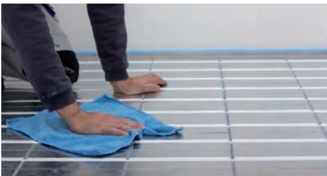
Vor Verlegung der IndorTec® 2E-SK Entkopplungsmatte sind die Systemelemente mit Lithofin KF Intensivreiniger von Staub und Schmutz zu befreien.
