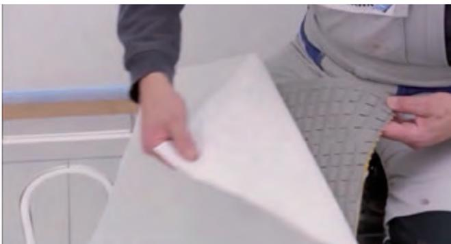
Zur Verlegung der selbstklebenden IndorTec® 2E-SK wird das rückseitige Silikonpapier entfernt und die Matte auf die gereinigten Systemelemente geklebt.
