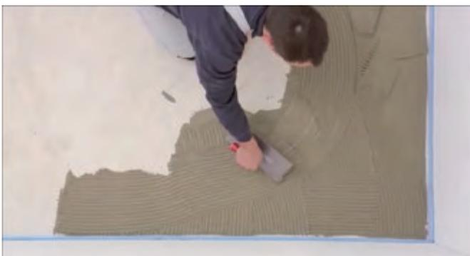
Klebemörtel zur Verlegung der Systemelemente auf den Untergrund mit geeigneter Zahnkelle (z.B.: 8 mm) auftragen. Vorzugsweise ist der Dünnbettmörtel X7G - Die Erfolgsformel zu empfehlen.
