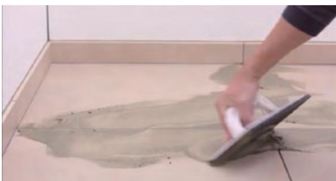
Nach Begehbarkeit erfolgt die Verfugung mit ARDEX G8S FLEX 1-6 - Zementgebundener Flex-Fugenmörtel. Fertig.
