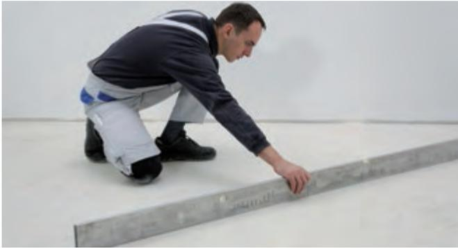
Prüfung des Untergrundes auf Eignung und eventueller Ausgleichsarbeiten (ARDEX K 39 - MicroTec Bodenspachtelmasse oder ARDEX K 15 - Glätt- und Nivelliermasse)
