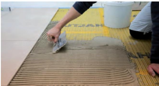
Jetzt wird die Entkopplungsmatte Zug um Zug mit ARDEX S 28 NEU - MICROTEC Großformatkleber abgespachtelt und dann das Dünnbett direkt mit geeigneter Zahnung aufgezehnt. Die Klebemörtelstärke zwischen IndorTec® 2E-SK und Unterkante Fliese / Naturstein sollte mind. 3 mm betragen.
