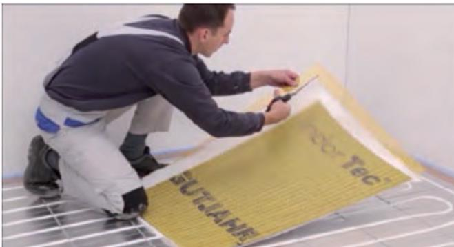
Bei der ersten Matte wird das überstehende Panzergewebe an der langen - und an der kurzen Seite abgetrennt und dann mit den abgetrennten Seiten an die Randdämmstreifen angrenzend, verlegt.
