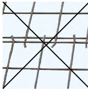
Falsche Gitterverlegung
